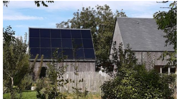
Panneaux formant la couverture complète d'une annexe, en Bretagne. La taille de la construction a été adaptée en fonction des dimensions des modules.
