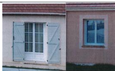
Fenêtres droites avec listel plus clair que l'enduit. Partie basse traitée en béton reconstitué ton pierre ou en briques
