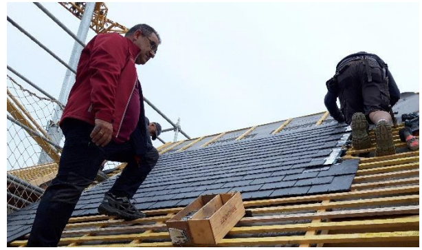
Panneaux thermiques sous une couverture en ardoises, au sein d'un Site Patrimonial Remarquable à Vendôme (41).
