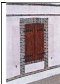
Fenêtre cintrée en arc surbaissé avec entourage en briques (prolongements supplémentaires des montants vers un bandeau de briques), coloris préconisé pour le lotissement
