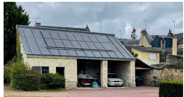
Panneaux photovoltaïques intégrés dans une couverture en zinc. Le rythme des panneaux et des joints à tasseaux du zinc coïncident parfaitement. Les panneaux sont encastrés dans la couverture ce qui contribue à les rendre très discrets. Bourgueil (37)
