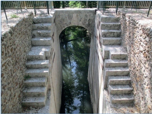
Ecluse de Boizard à Pontgouin
