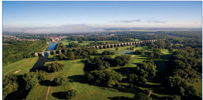
L'Aqueduc, un vestige inachevé à proximité du Château de Maintenon. Il devait, avec de grosses canalisations, faire traverser l'eau captée de Pontgouin vers Versailles, en permettant ainsi de garder un dénivelé suffisant, en surplombant la vallée de l'Eure.
