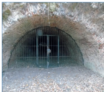
Siphon maçonné en pierre et en brique
